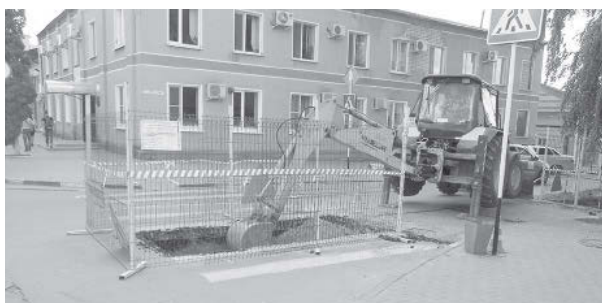
Один из объектов - участок теплосетей на перекрестке улиц Горького и Свердлова
