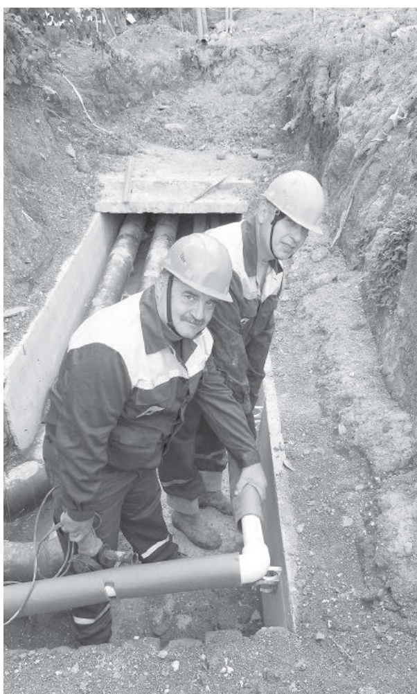
Слесари Виталий Токан и Геннадий Окоороков ведут монтаж участка системы ГВС на улице Калинина
